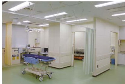
新規稼働の救急外来処置室
