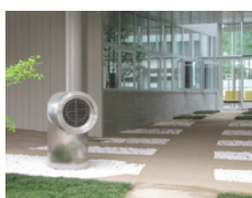
室外のクールチューブ(吸込み)
